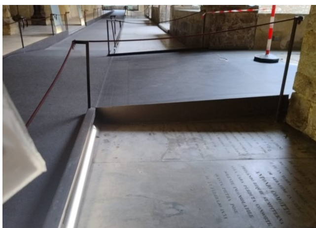
Rampa di accesso al Chiostro dei morti lunga 150 cm e pendenza moderata Ingresso con piccolo scalino di 4 cm
